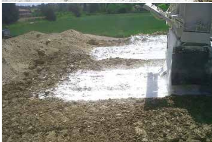
8 e 9. L'Uniroad SP™, con un valore di TEP pari al 37,27% inferiore alla soglia del 40% stabilita dal SÉTRA e rispetto all'ossido di calcio tradizionale, è l'unico legante a ridotta emissione di polveri
